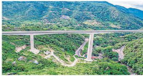
Puente La Honda tiene 385 metros de largo y 83 de altura máxima. / Foto: Cortesía
