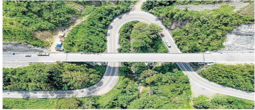
Esta importante obra agilizará el trayecto entre Cúcuta y Pamplona. / Foto: Cortesía
